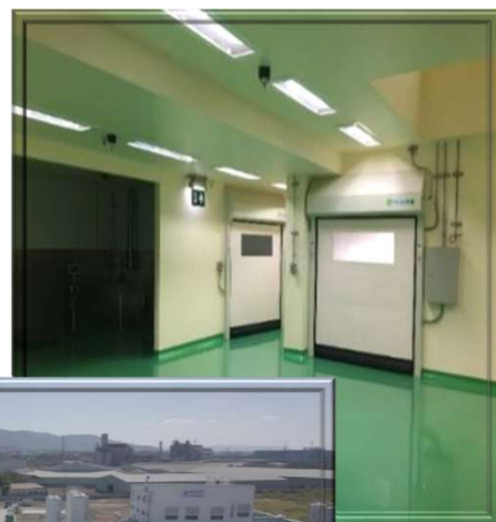
(上) 建屋内 部の施工事例
