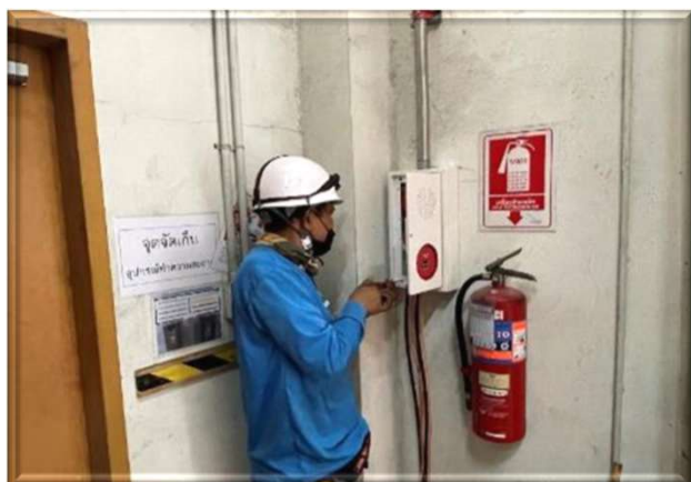
防消火設備の点検
